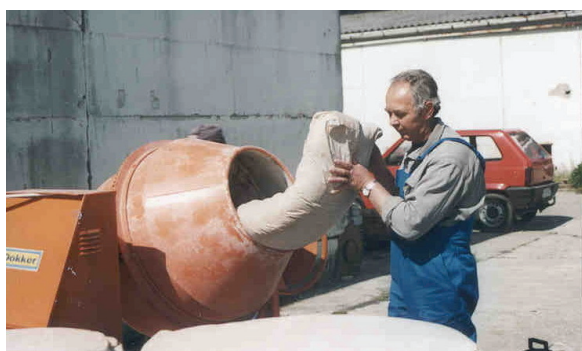
1. fénykép Természetes zeolit betöltése a betonkeverőbe
