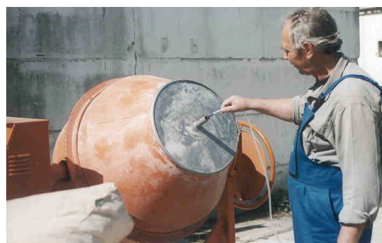
2. fénykép Porlasztófej behelyezése a betonkeverő fedelén kialakított csőbe
