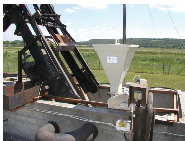
7. fénykép FKZ adagoló a Kaposszekcsői Szennyvíztisztító Telepen
