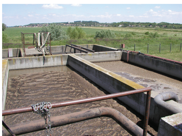
6. fénykép A Kaposszekcsői Szennyvíztisztító Telep anoxikus és aerob medencéje
